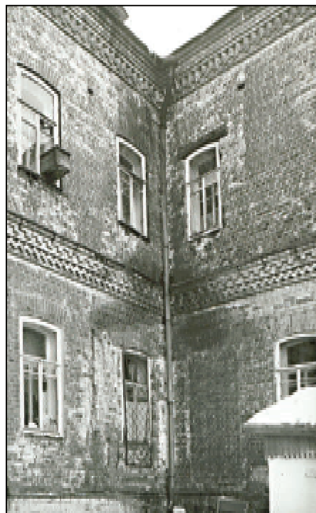
Внутренний дворик здания на проспекте Ленина, 44. 1989 г.
